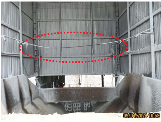
รูปที่ 3-15 ระบบสเปรย์น้ำบริเวณที่ทำให้เกิดฝุ่นละออง
