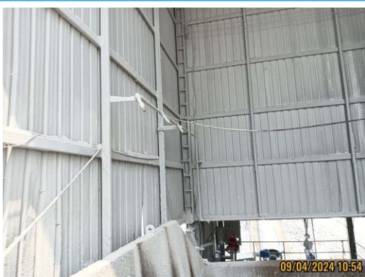
รูปที่ 3-17 ระบบสเปรย์น้ำบริเวณที่ทำให้เกิดฝุ่นละออง
