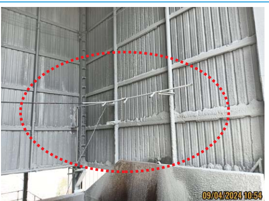
รูปที่ 3-18 ระบบสเปรย์น้ำบริเวณที่ทำให้เกิดฝุ่นละออง
